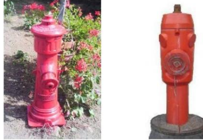
Ilustrația nr. 6: Exemple de stâlpi pe țeavă 80
