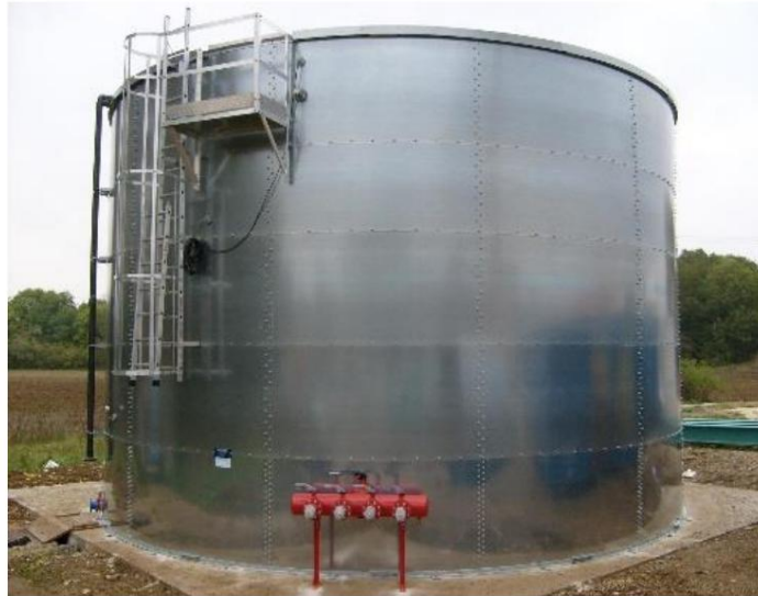
Ilustrația nr. 10: rezervor aerian cu dispozitiv de aspirare la distanță
