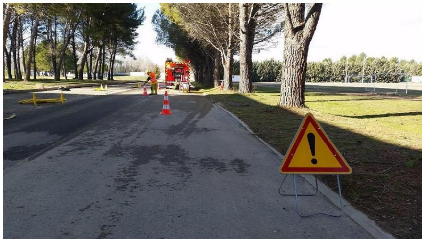
Ilustrația nr. 3: Securizarea zonei de lucru (Credit foto @ ENSOSP)
