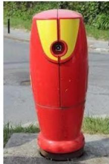
Ilustrația nr. 8: Exemple de stâlpi pe țeavă de 150
