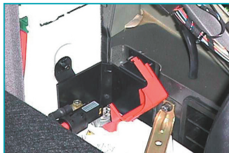
Sistem automat de deconectare
